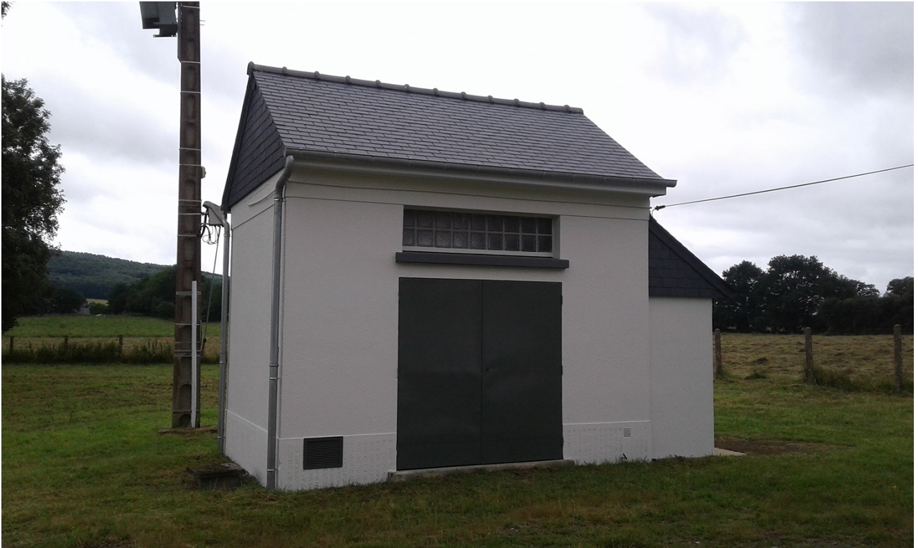
Station d'eau potable de la Chevrolière (Commune de Saint Georges sur Erve)
